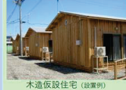
木造仮設住宅（設置例）
