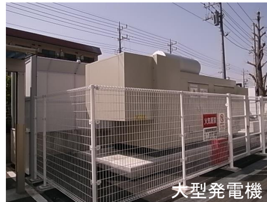
大型発電機 Emergency generator
